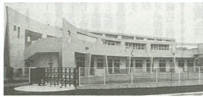
▲国分寺台文化センター・ケアセンター
