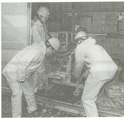
防災備蓄倉庫を点検
