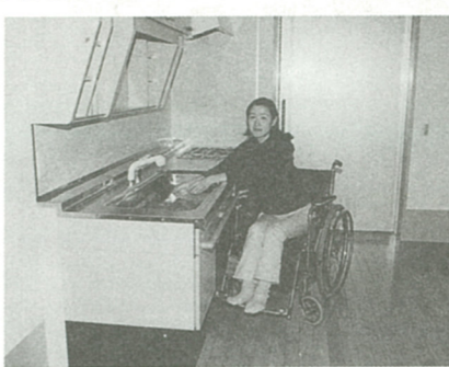
流し台などにも手すりを設置(杉久保住宅)
