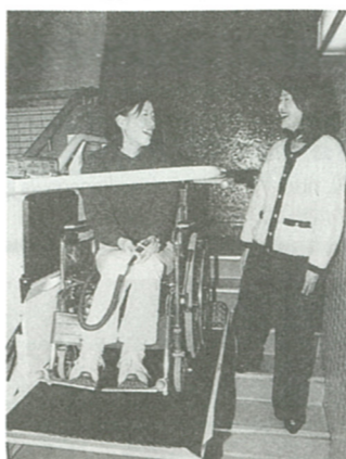
サポートセンターの昇降機
