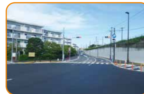
市道62号線、斜面を削って歩道を新設
