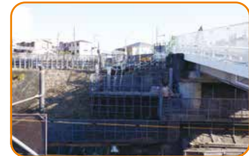
整備中の横浜駅側歩道橋
