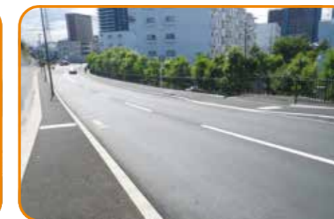
市道62号線、斜面を削って歩道を新設
