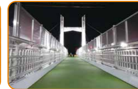
安全性向上のため夜間照明を設置
