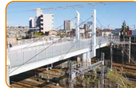
完成後の海老名駅側歩道橋
