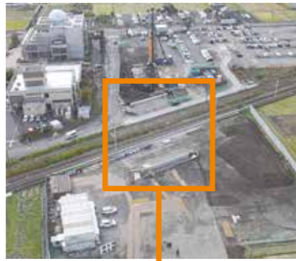
アンダーパス完成部分
