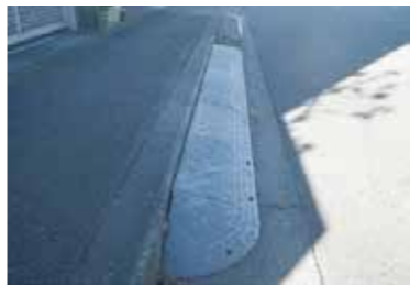
公道に設置された乗り上げブロック
