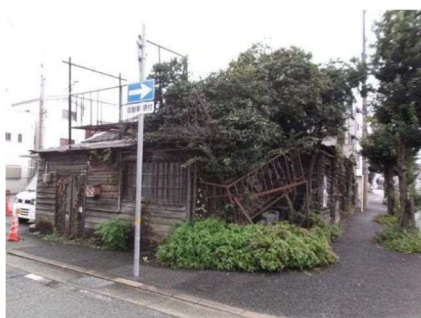
写真④：前面道路へのはみ出し
