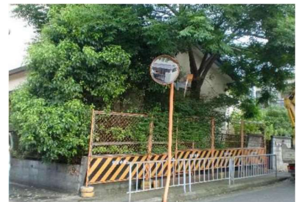
写真③：前面道路へのはみ出し
