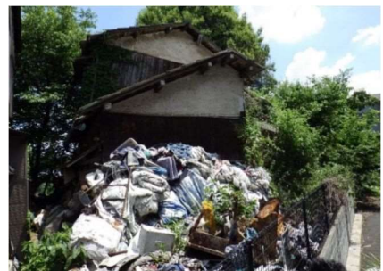
写真③：ごみの放置
