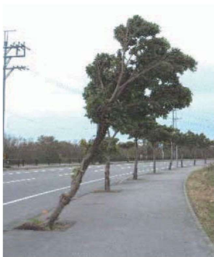
写真①：不自然な傾斜
