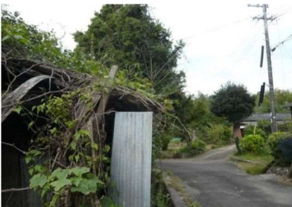
写真①：枝のはみ出し
