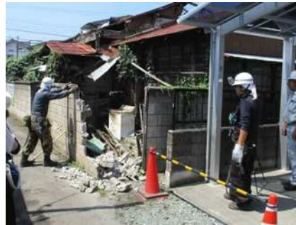
写真②：塀の破損
