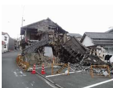
写真①：既に倒壊している
