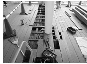
ウッドデッキ補修工事
