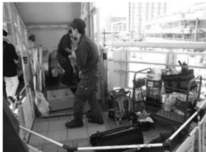
エスカレーター年次修理
