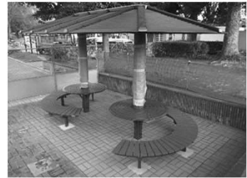
《休憩施設改修工事》
