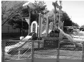
《遊具改修工事》
