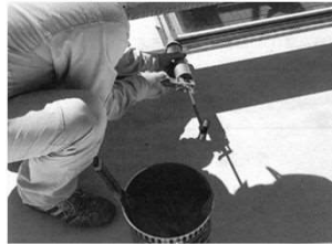
屋根補修工事
