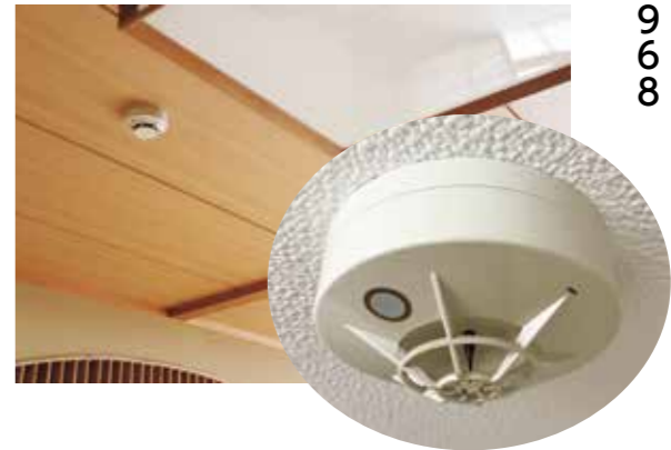
室内の熱や煙を感知し、音や音声で火災の発生を知らせます
