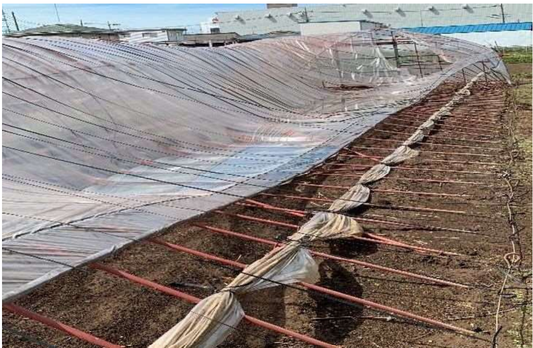
（写真）台風被害により倒壊した温室
