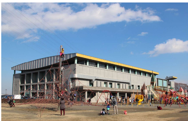
【海老名運動公園】 (総合体育館)
