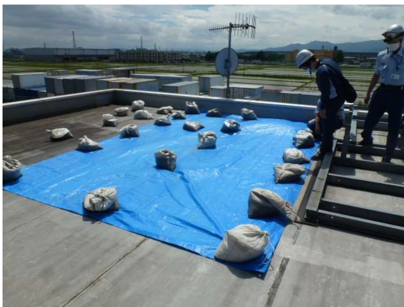
※消防署南分署の屋上の状況
