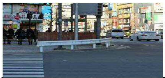
ガードレールの補修
