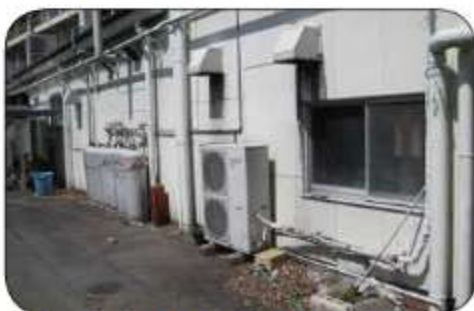
室外環境異常による配管の劣化
