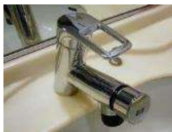
節水コマを取り付けできない蛇口 (レバー式水栓)
