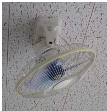
天井に設置された扇風機（攪拌用）
