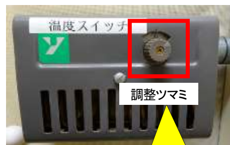
換気ファン用サーモスイッチ
