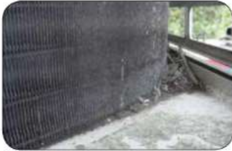
熱交換器下部の腐食
