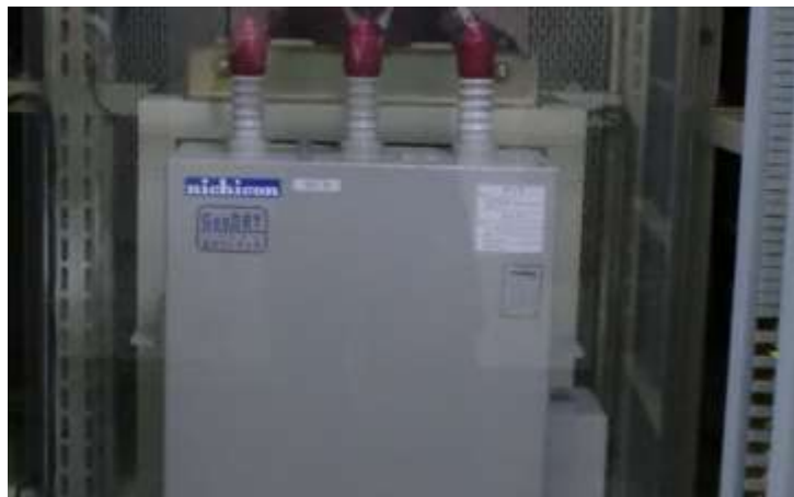
進相コンデンサ（変圧器の中に所在）
