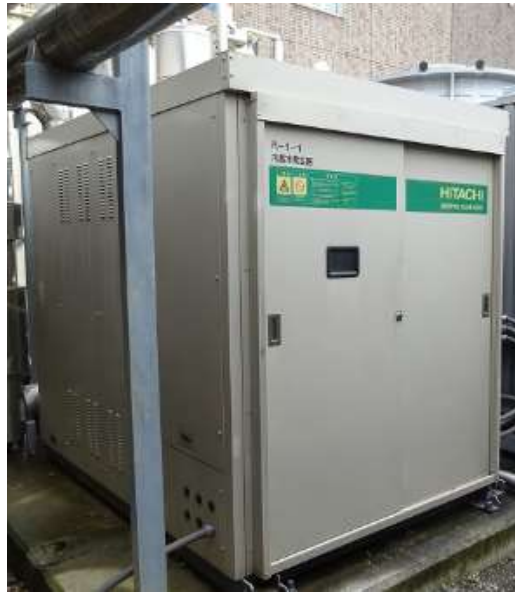
冷温水発生機（屋外に設置したケース）
