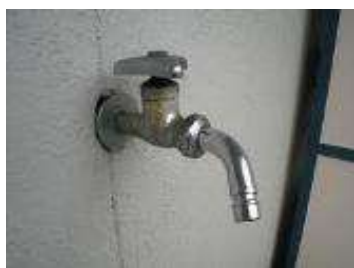
節水コマを取り付けできる蛇口 (一般用蛇口)
