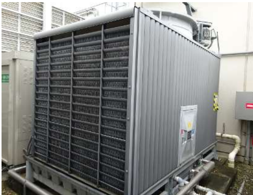
冷却塔（屋外に設置したケース）
