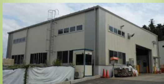
不燃物処理棟
