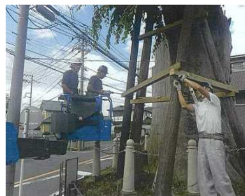
海老名の大櫓修理状況
