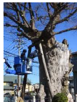
海老名の大櫓修理状況
