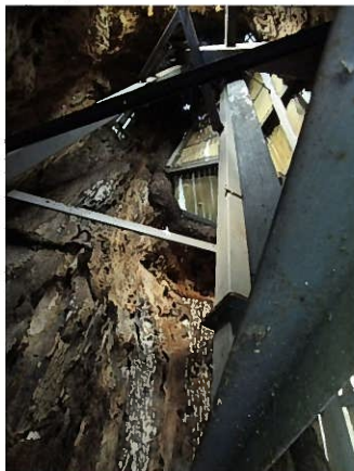
【鉄骨支柱錆止舗装箇所（樹幹内部）】
