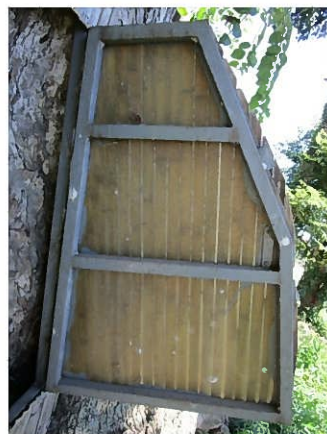
【鉄骨支柱錆止舗装箇所（樹幹内部）】
