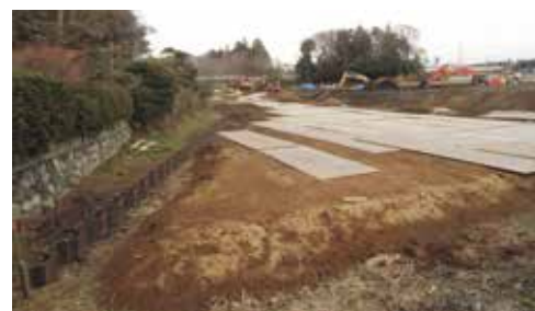
整備中の第1工区(市道2152号線側から)
