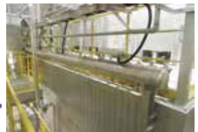
【ハイブリッドバグフィルタ】 排ガスをろ過してきれいに
