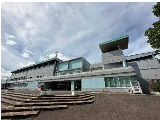
海老名運動公園総合体育館
