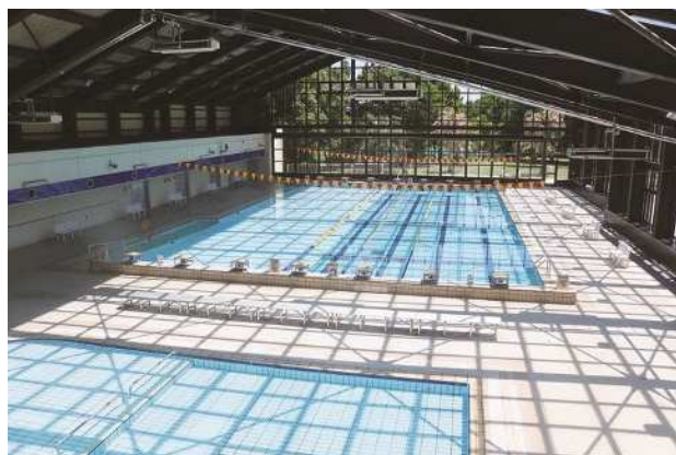
海老名運動公園屋内プール
