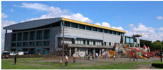
海老名運動公園総合体育館
