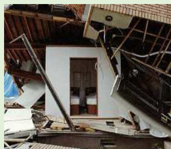
耐震シェルター
