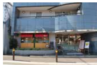
施工内容 店舗外装工事、 看板設置
