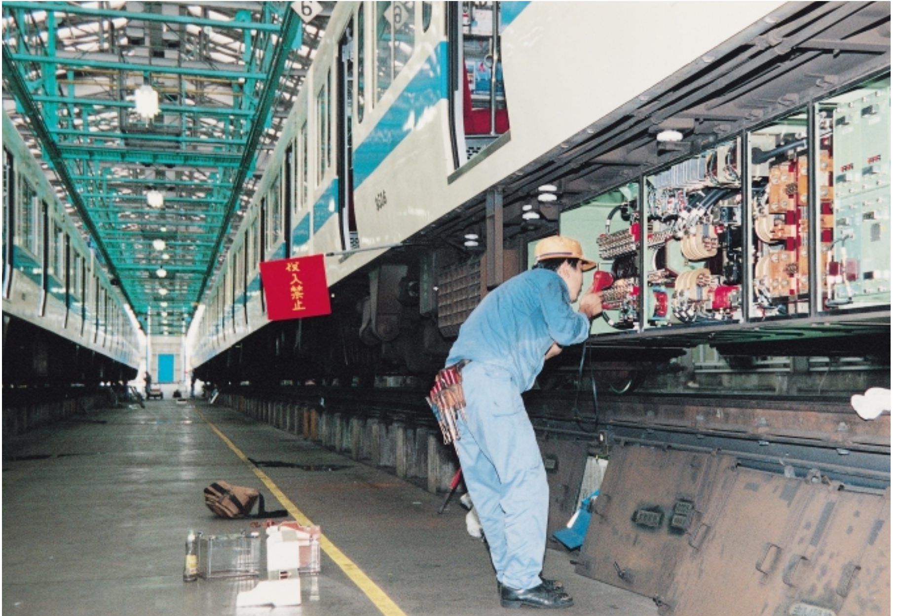
電車の「健康診断」を行う検車区の作業風景
