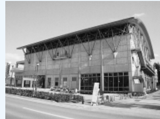
▲北部公園体育館
