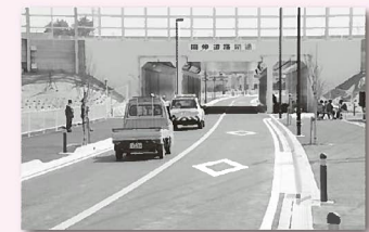
～南部の利便性向上～ 南伸道路開通
