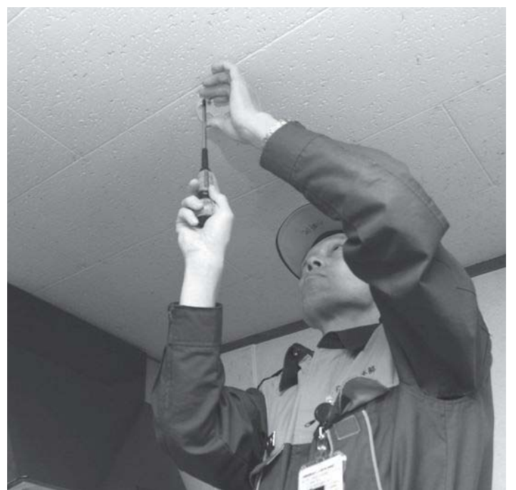
▼警報器の取付けの様子
