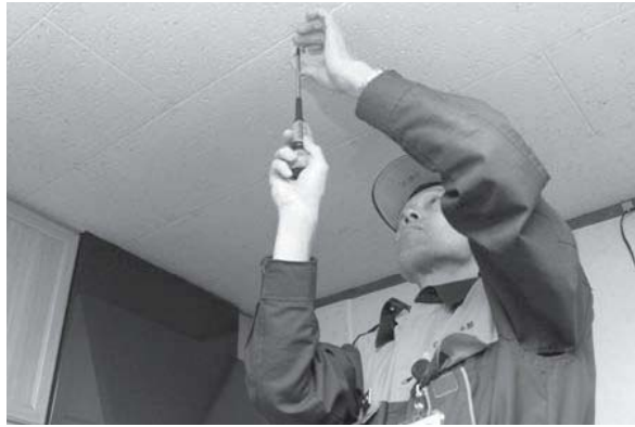
▶住宅用火災警報器取り付けの様子(写真上)同警報器の一例(写真右)
