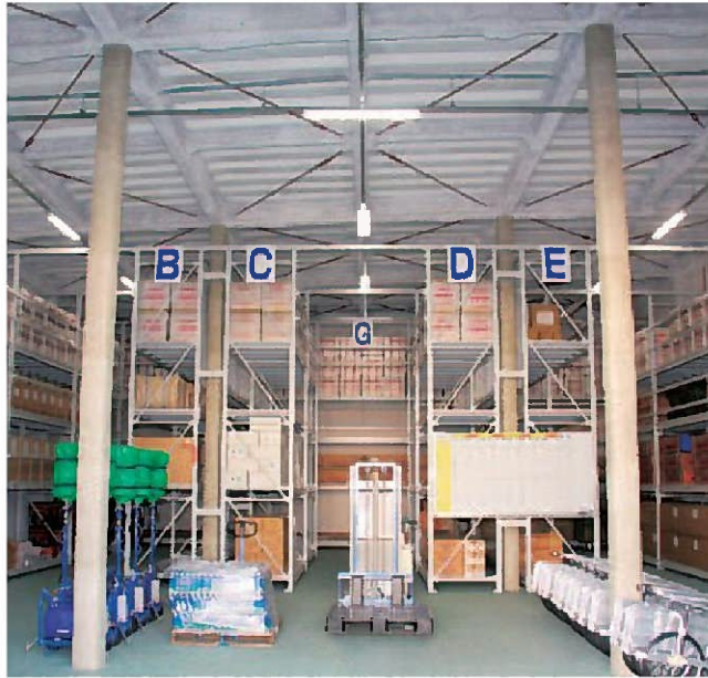
▲大型防災備蓄倉庫内部の様子
