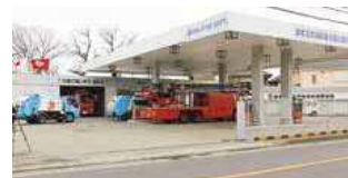
▲停電時にも給油できるように非常用発電設備も設置
