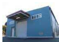
▲大型防災備蓄倉庫
