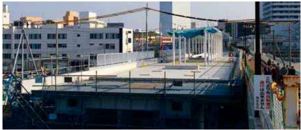
▲工事中の新自由通路
