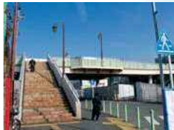
▲撤去される階段。最寄りの階段は小田急駅舎側の階段です
