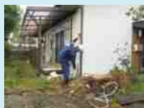
▲家屋の傾きを測定
