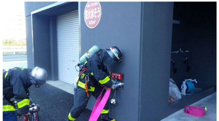
【連結送水管送水準備作業】
