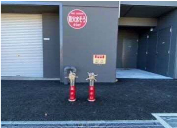
【採水口・連結送水管送水口】
