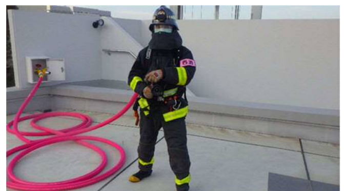
【上階放水口より放水】
