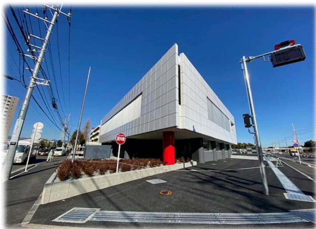
消防署西分署(令和3年4月開署)
