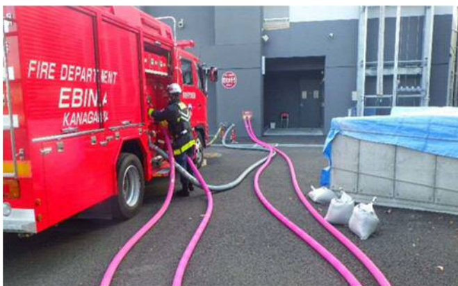
【連結送水管送水状況】
