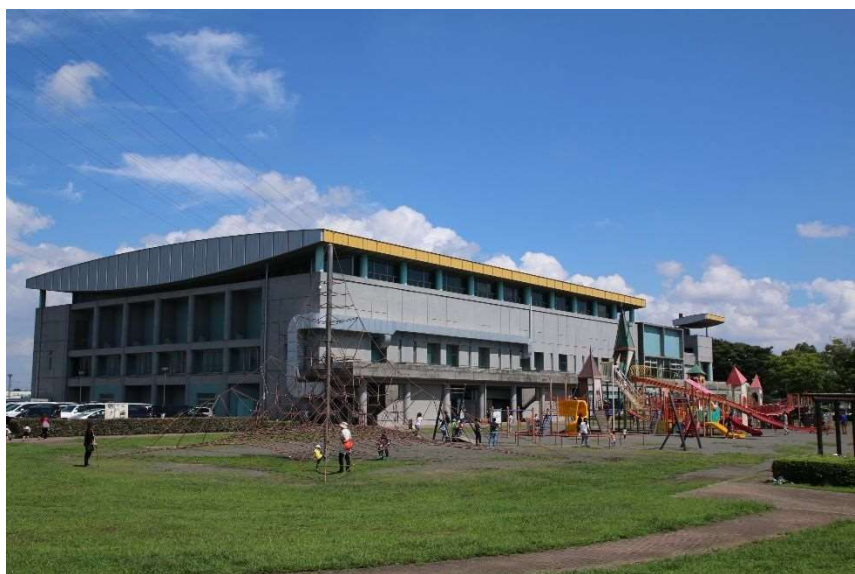
海老名運動公園総合体育館
