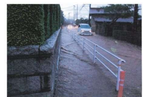
市内の浸水状況
