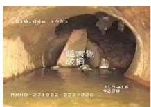
破損した管
