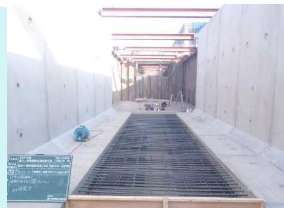
▲国分一号幹線排水路でのL型水路の施工状況
