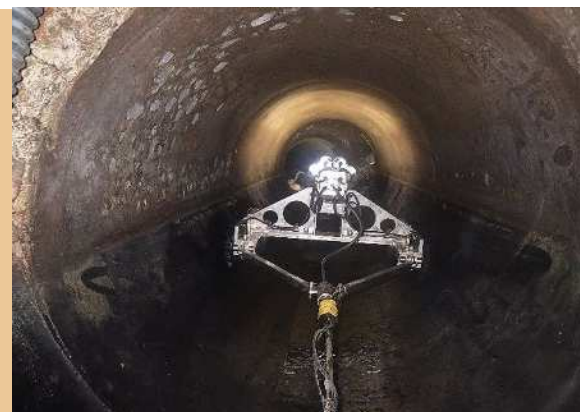
▲管渠詳細調査委託 (TVカメラ調査)
