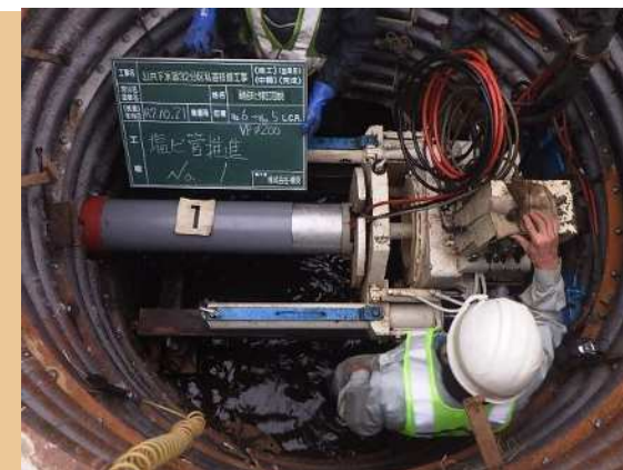
▲公共下水道32分区での本管設置の施工状況
