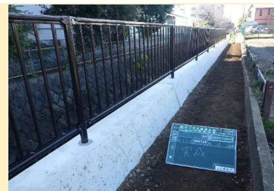
▲国分一号幹線排水路フェンス改修工事
