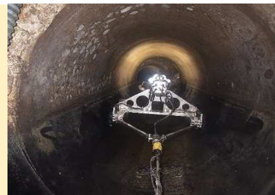
▲管渠詳細調査委託 (TVカメラ調査)
