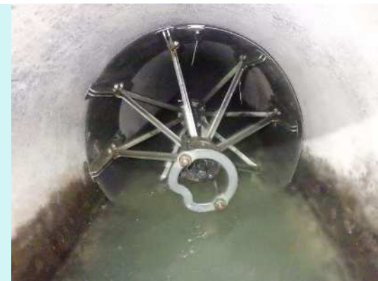
▲マンホール継手部耐震化工事 マグマロック取付
