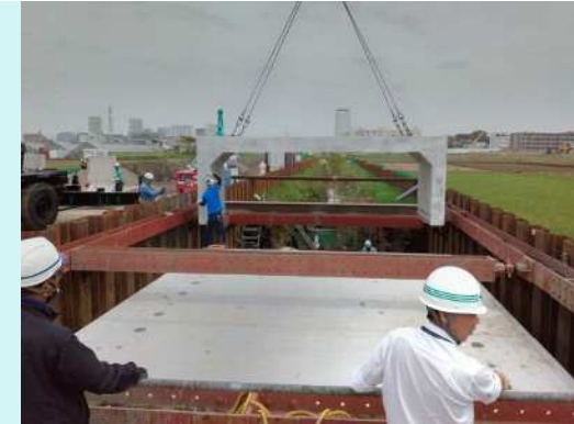
▲国分一号幹線排水路改修工事(一般部) 暗渠設置
