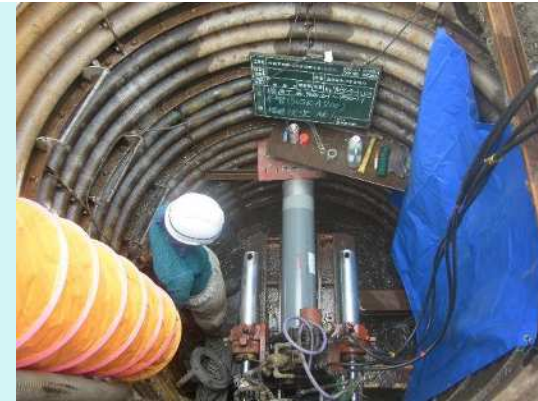
▲公共下水道36分区枝線工事(その3) 本管設置
