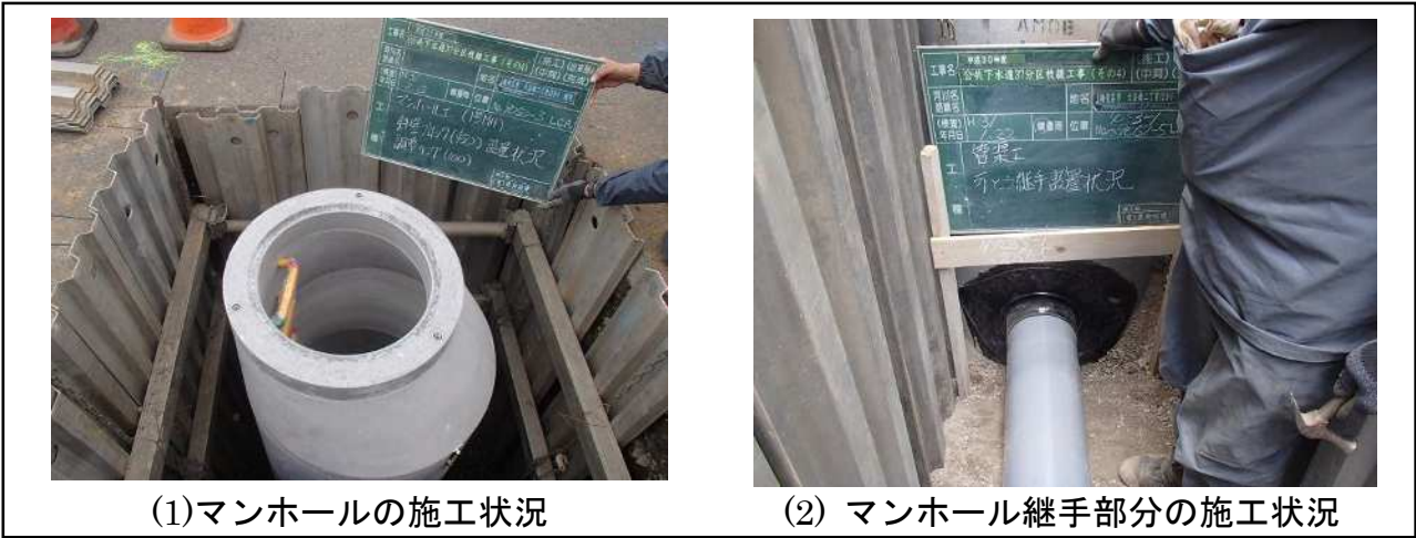
写真 5-1 海老名市での可とう性継手設置例
