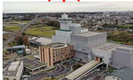
高座クリーンセンター 処理能力:245 t/日(122.5 t/日×2炉)
