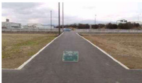
道路整備の様子
