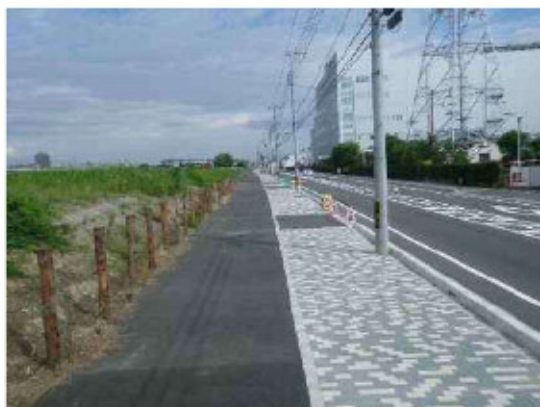
市道53号線 整備状況
