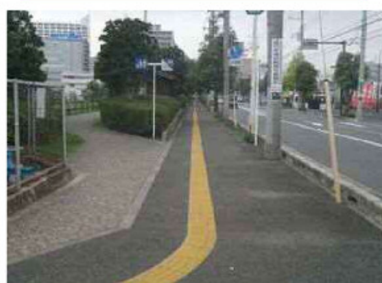
バリアフリー歩道 整備状況
