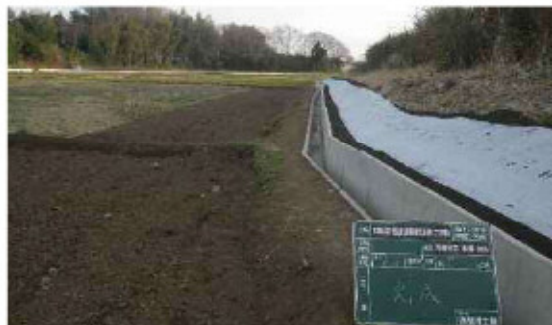
水路補修の様子
