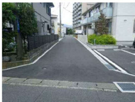
市道1424号線 整備状況
