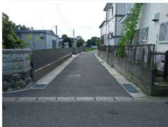
市道487号線 整備状況
