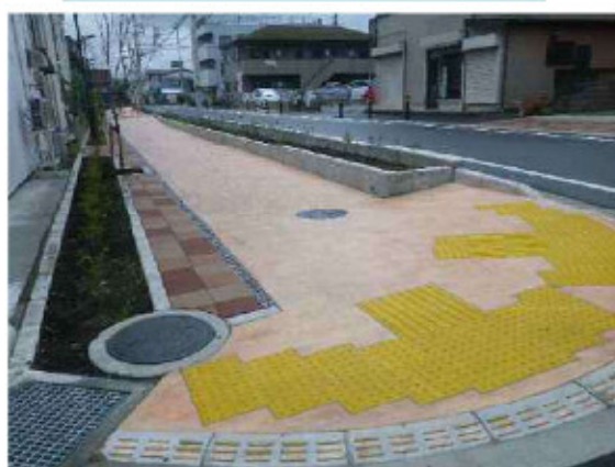
市道23号線 整備状況
