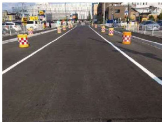
市道61号線 整備状況
