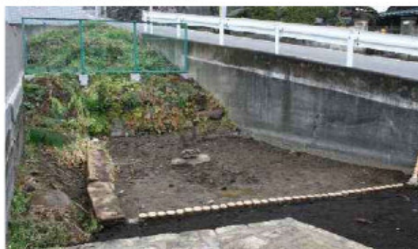
浅井の水整備工事
