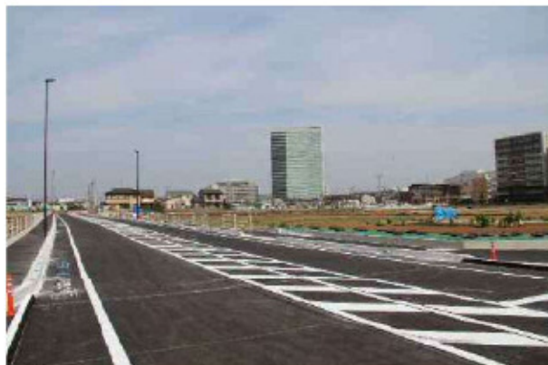
(仮称)上郷河原口線 整備状況
