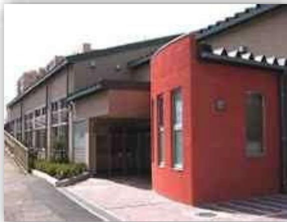
座間市立リサイクルプラザ
