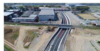
(仮称)市道53号線バイパス竣工
