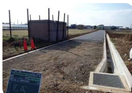
水路整備の様子
