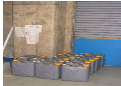
次亜塩素酸ソーダ保管状況
