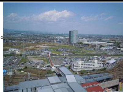
海老名駅西口土地区画整理事業 工事実施状況
