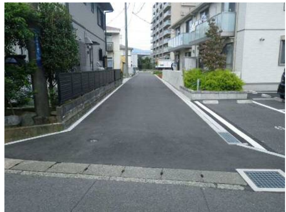
市道1424号線 整備状況
