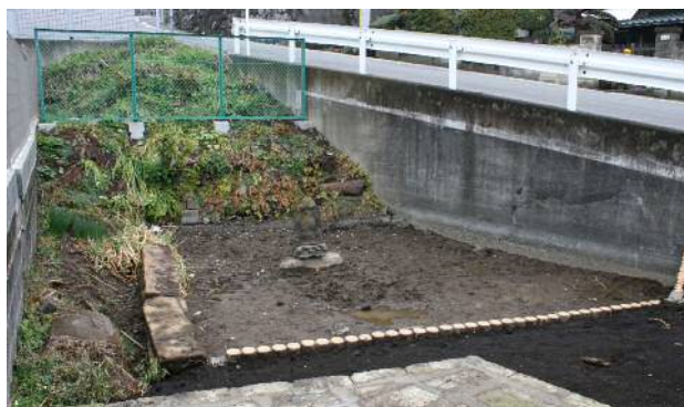
浅井の水整備工事
