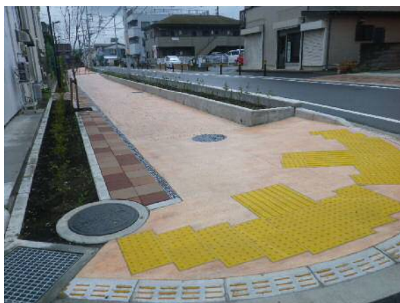
市道23号線 整備状況
