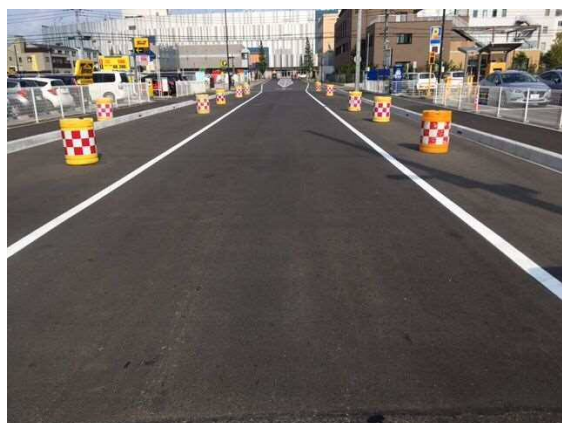
市道61号線 整備状況
