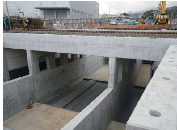
(仮称)市道53号線バイパス 整備状況
