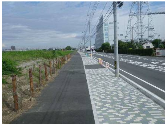
市道53号線 整備状況
