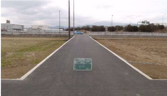
道路整備の様子
