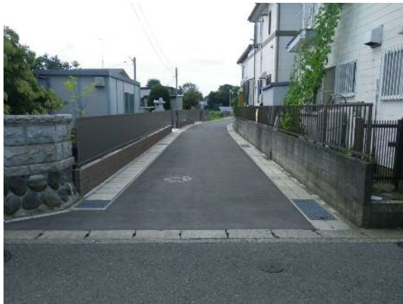
市道487号線 整備状況
