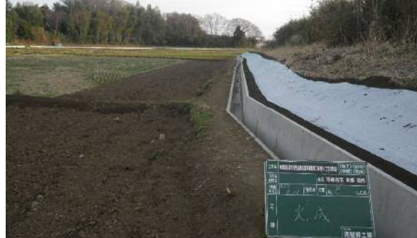
水路補修の様子
