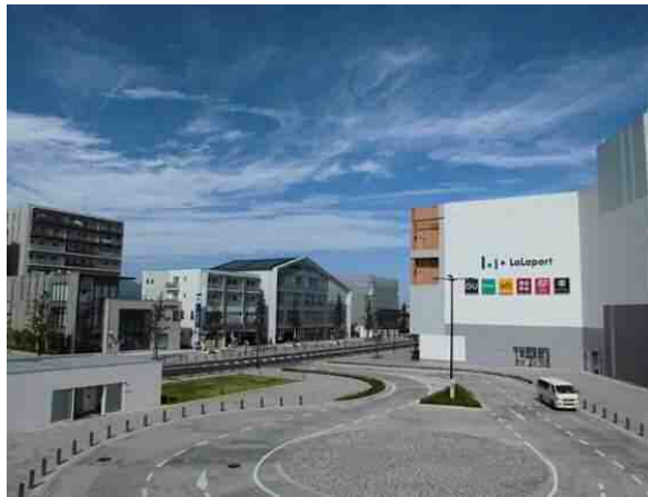
海老名市扇町 西口中心広場
