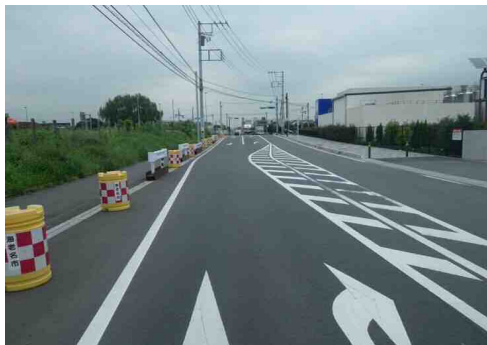
市道53号線 整備状況
