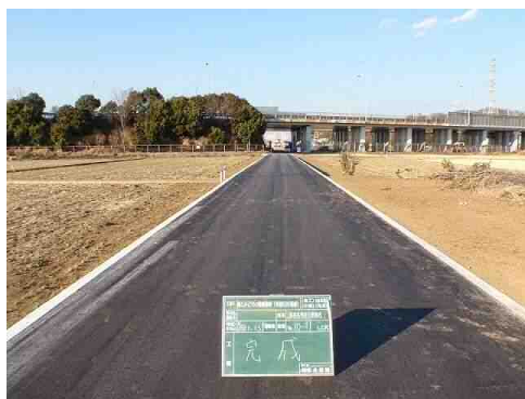
道路整備の様子
