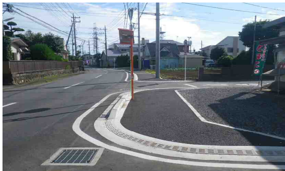
市道8号線(中河内) 整備状況
