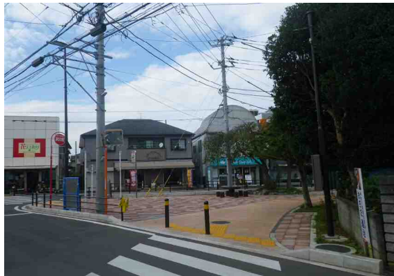
市道23号線 整備状況
