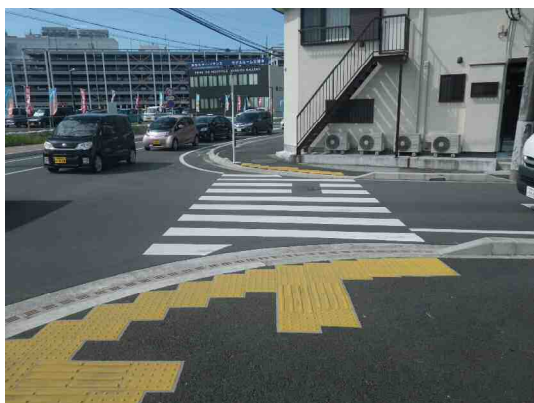
市道62号線整備状況
