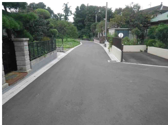
市道912号線 整備状況
