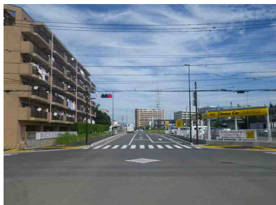
市道307号線バイパス整備状況
