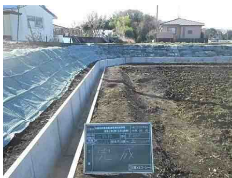
水路補修の様子
