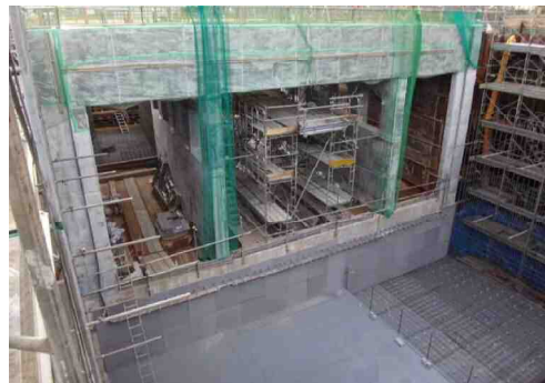
市道53号線バイパス 整備
