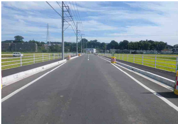
市道2号線 整備状況
