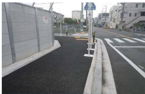
市道12号線 整備状況
