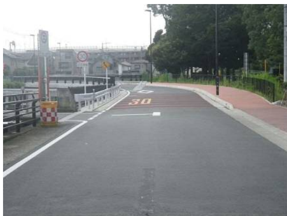
市道53号線 整備状況
