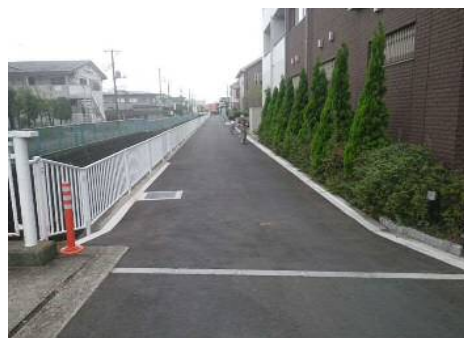
市道398号線 整備状況
