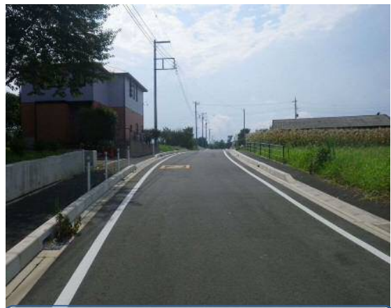
市道738号線 整備状況
