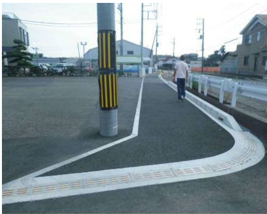
市道8号線 整備状況
