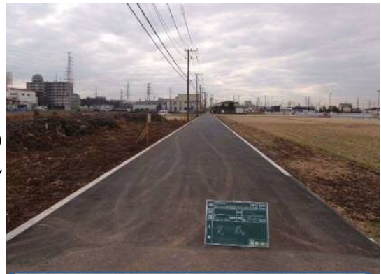
道路整備の様子
