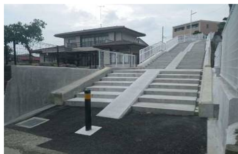
市道1081号線 整備状況
