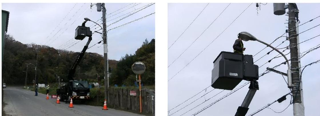
写真3-1 道路照明灯の点検状況
